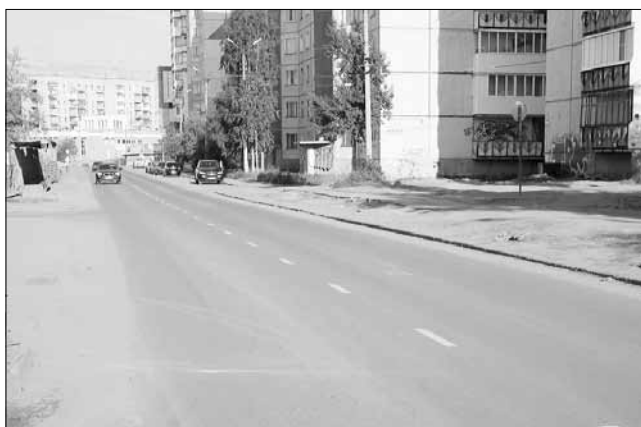
■ Дорожное полотно на улице Гайдара отремонтировано
