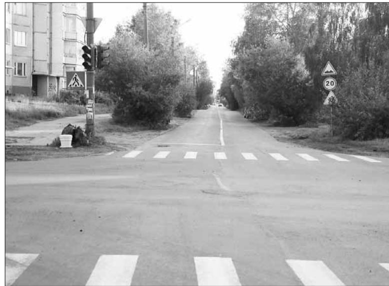
■ Дорога на улице Кедрова уже капитально отремонтирована
