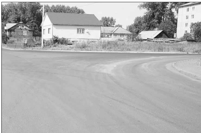
■ Дорожный ремонт пришел на о. Краснофлотский
