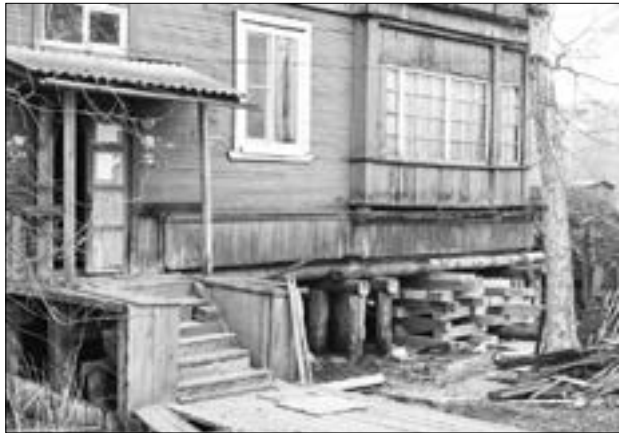
■ В 2017 году в Северном округе запланирован капремонт девяти домов.
