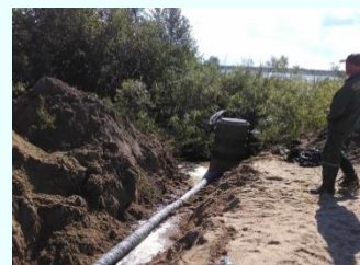
Устройство дренажной системы по ул. Лодемская
